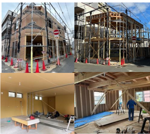
【建設中写真 ※耐力壁】
