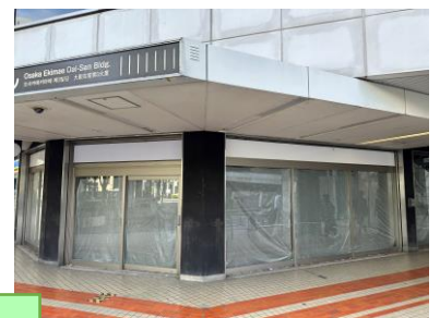
◀ 改装前室内写真 ▶
