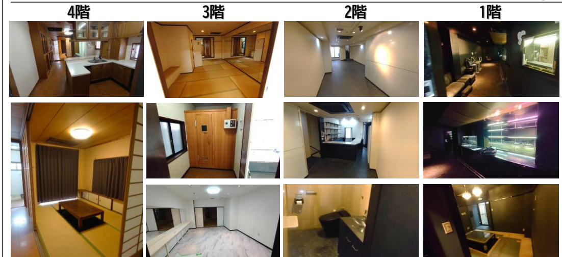
【改装前室内写真】
